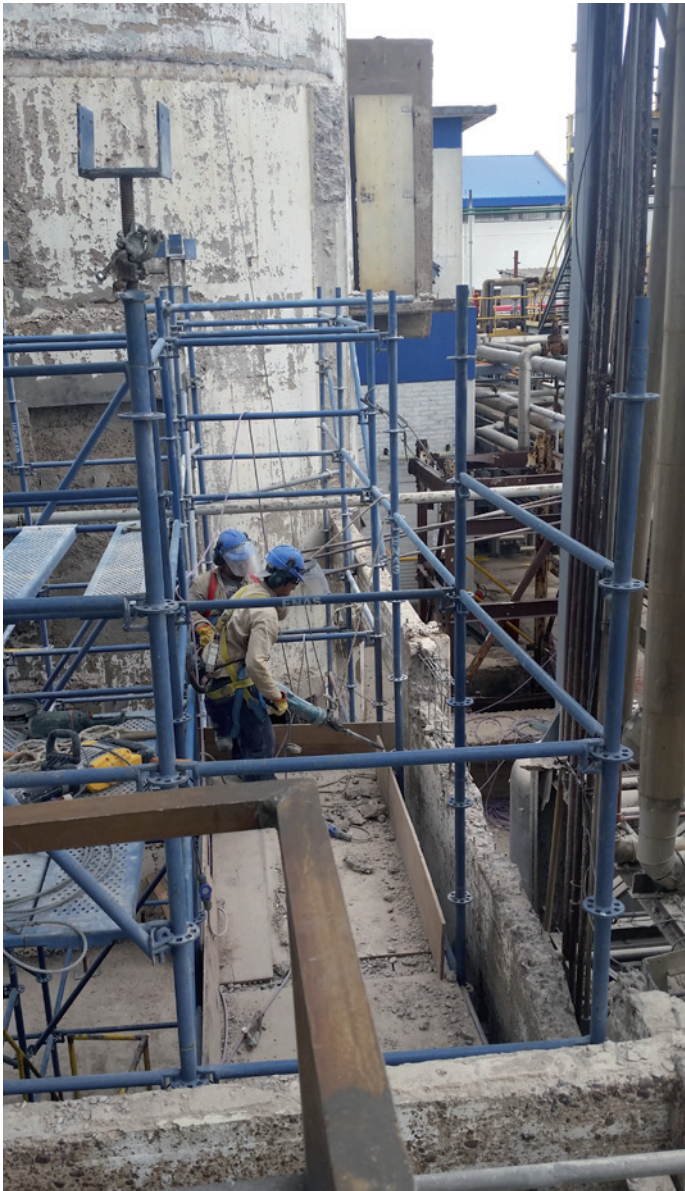
Demolición de losa de hormigón armado, Bunge Campana
