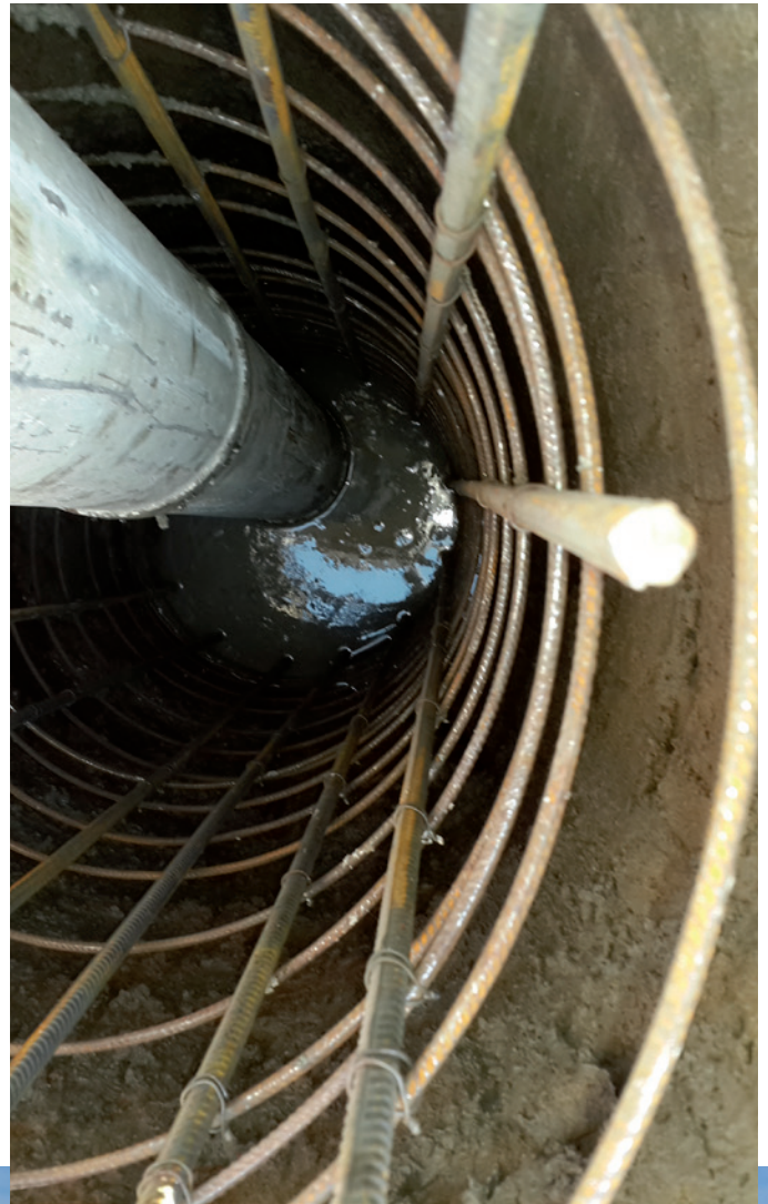
Llenado de pilotes por flujo inverso.
